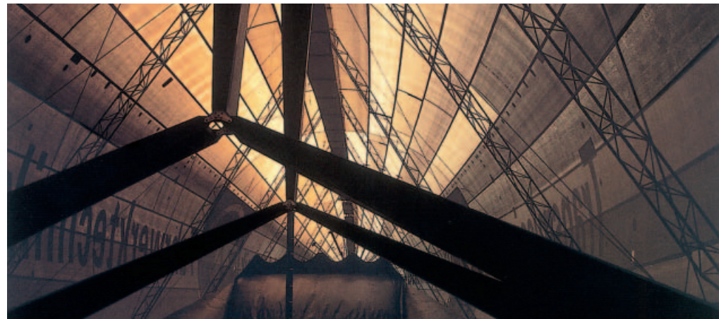
Die starre Struktur des Zeppelin NT vor dem Überzug der Hülle in der Werfthalle in Friedrichshafen.
